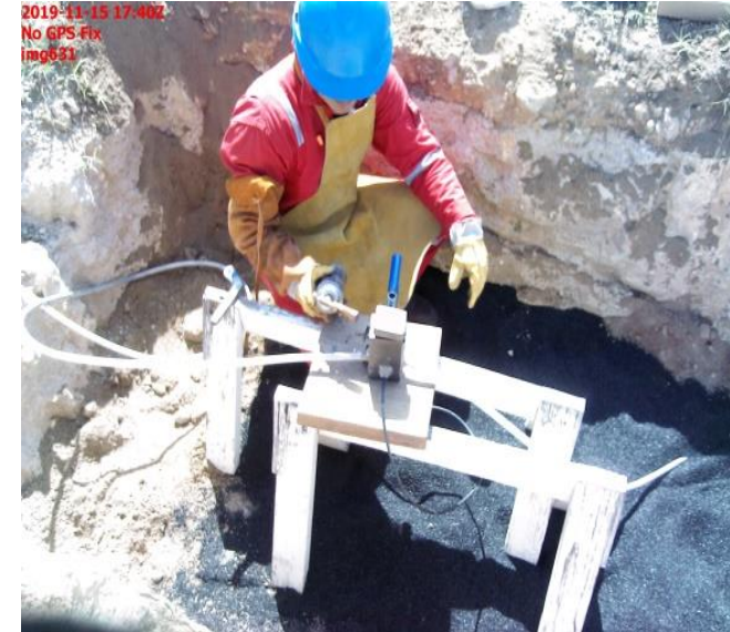
SOLDADURA EXOTÉRMICA
