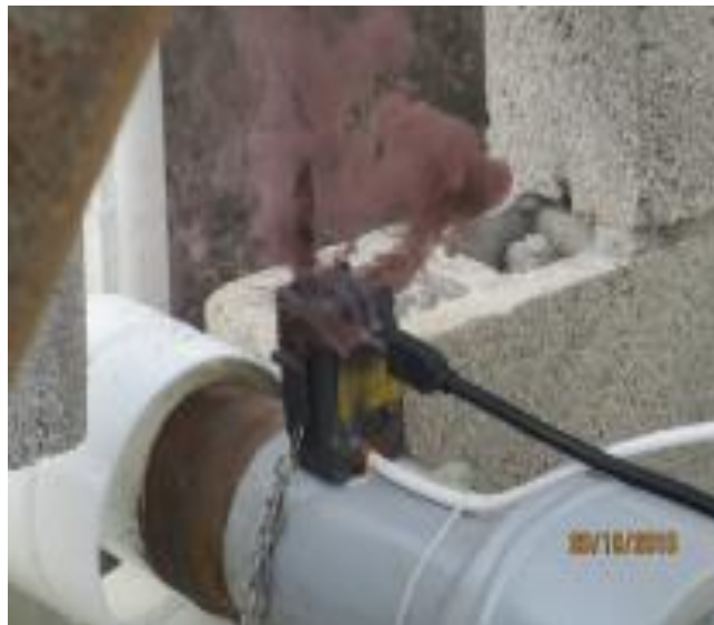
SOLDADURA EXOTÉRMICA
